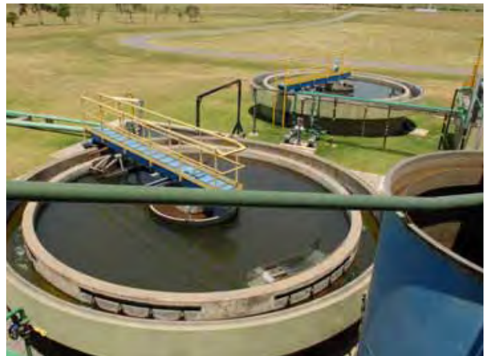
Planta de tratamiento de agua en la planta de Zárate
