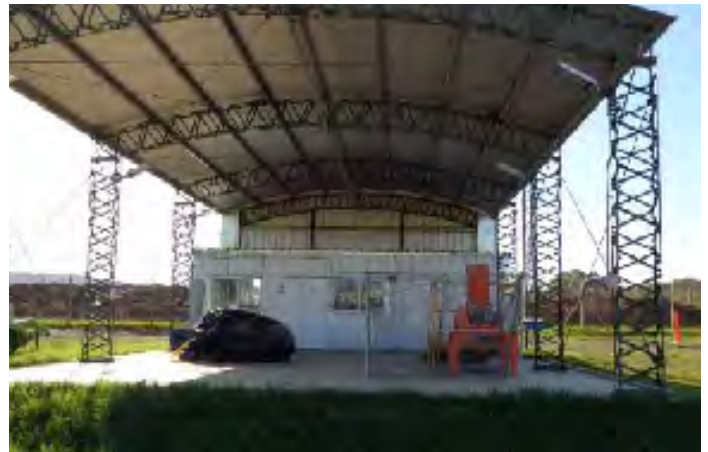
Área de acumulación temporaria de residuos
